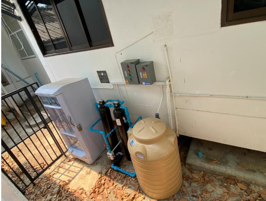
ระบบผลิตน้ำใช้ของห้องปฏิบัติการเทคนิคการแพทย์ โรงพยาบาลสองแคว
