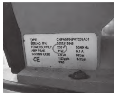
ป้ายบอกรายละเอียดเครื่องสูบน้ำคลอรีน
